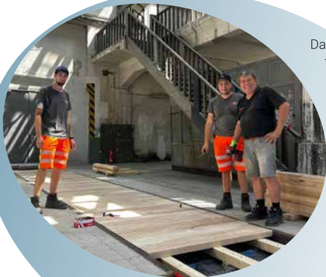
Bauhofleiter Josef Hofmann (rechts) mit seinen Kollegen vom Bauhof beim Aufbringen eines Bretterbodens.
