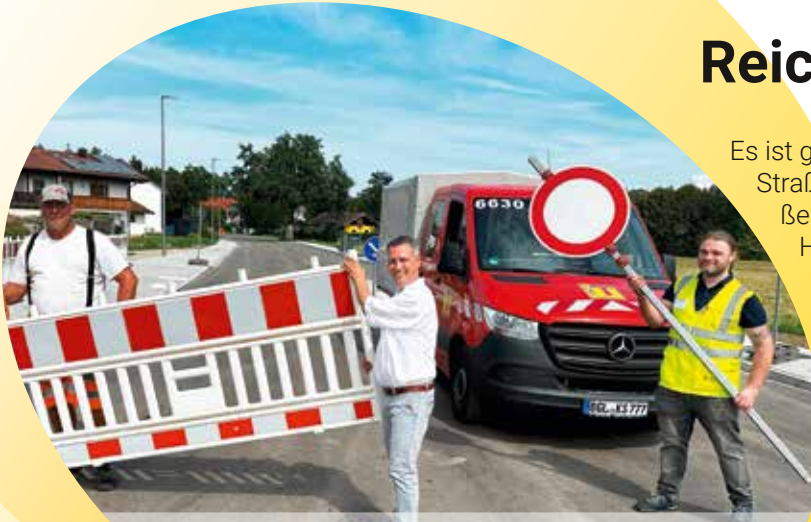
Uwe Horstmann, Polier der Baufirma LKS, Bürgermeister Markus Hiebl und Andreas Stephl vom städtischen Tiefbauamt räumten die letzten Sperrbaken von der Straße.
