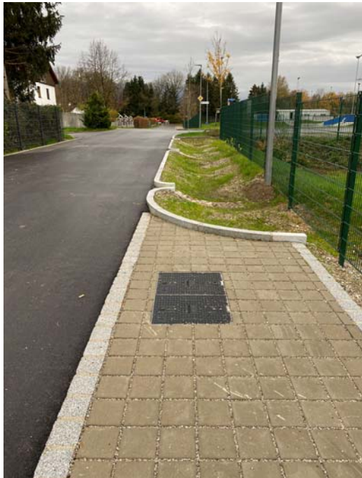
Einer der Zusätzlichen Schächte im Bereich der Kläranlage
