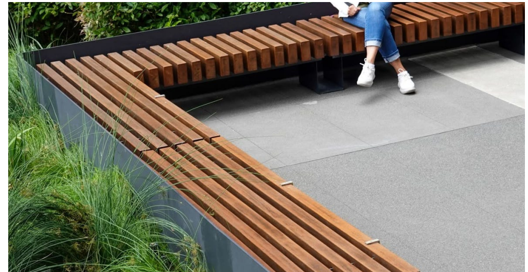
Referenzbild: Lattung durch Ecklösung sowohl quer als auch längs zur Sitzkante
