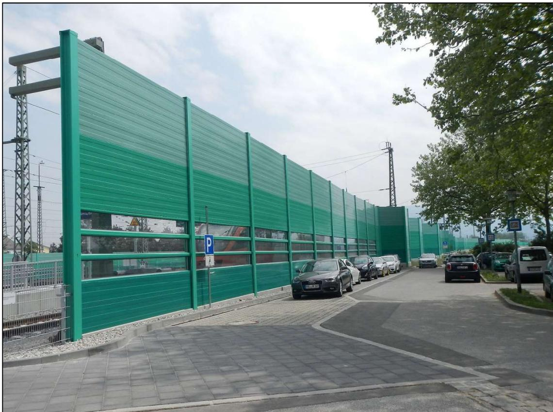
Abbildung 14: Blick auf die 6 m hohe Lärmschutzwand im Süden der Gleise
