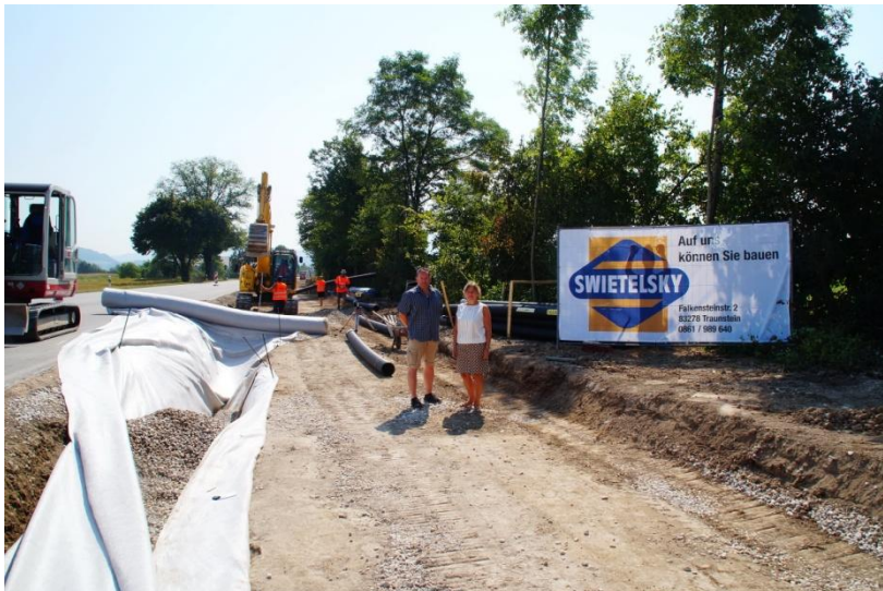
Oliver Machnicki, Bauleiter der Firma Swietelsky und Maria Enderle vom städtischen Tiefbauamt besichtigen die Baustelle an der Kreisstraße BGL2.
