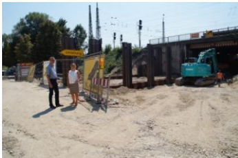
Maria Enderle vom städtischen Tiefbauamt und Peter Egger vom städtischen Ordnungsamt besichtigen die Baustelle „Drittes Gleis“.
