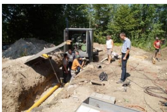
Die ESB-Gasstation an der Georg-Wrede-Straße wurde für den Straßenendausbau versetzt.
