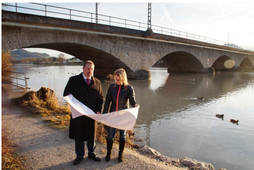
Bürgermeister Josef Flatscher und Hauptamtsleiterin Andrea Schenk nehmen die Eisenbahnbrücke noch einmal vor den Bauarbeiten zur Sohlabsenkung in Augenschein.
