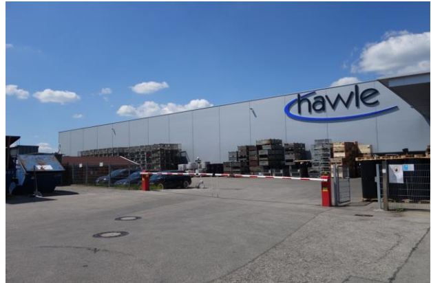
Abbildung 4: Fa. Hawle GmbH am Ende der Liegnitzer Straße (B). (27.05.2020)
